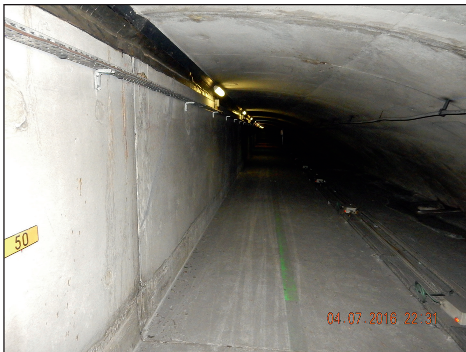
Des investigations et des mises en sécurité peuvent devoir être effectuées dans des tunnels.
