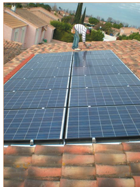
Les travaux d'installation des panneaux photovoltaïques terminés.
