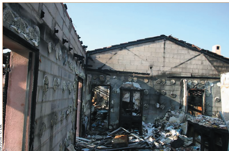
Habitation après sinistre.
