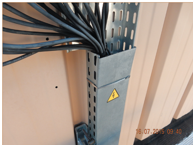
Cablage des champs endommagés
