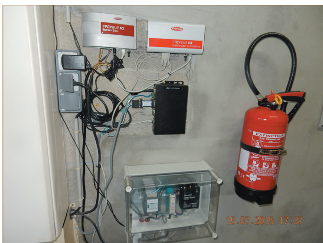
Cablage et montage empirique
