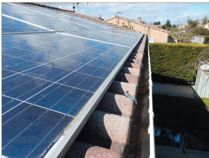
Intégration partielle des panneaux photovoltaïques
