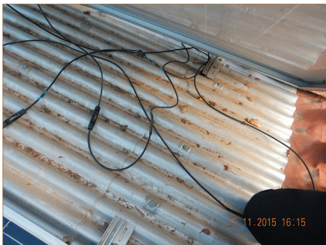
Cablage défectueux des champs
