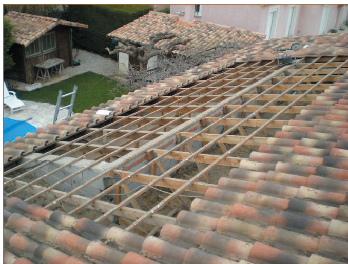
Pendant les travaux d'installation des panneaux photovoltaïques
